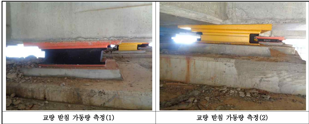
【사진 3.3.15】 교량받침 이동량 측정
