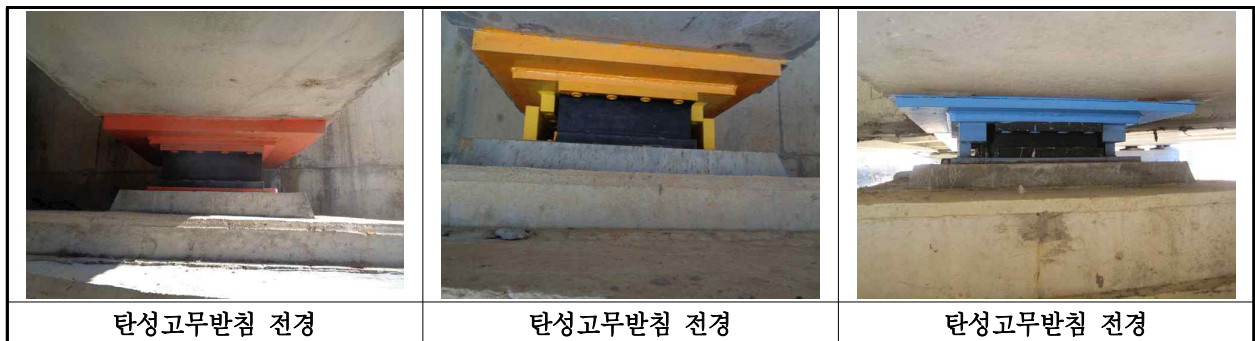
【사진 3.3.37】 교량받침 전경
