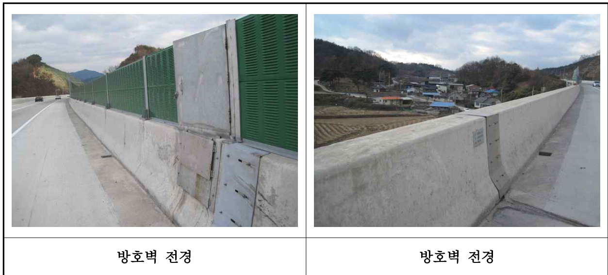
【사진 3.3.49】 방호벽 및 중앙분리대 전경
