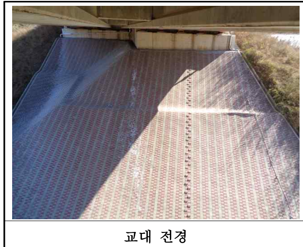
【사진 3.3.8】 교대 전경
