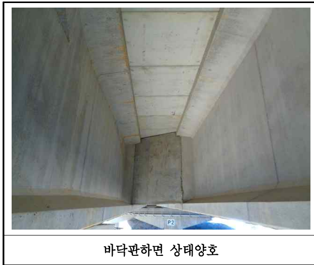
【사진 3.3.3】 바닥판하면 손상현황
