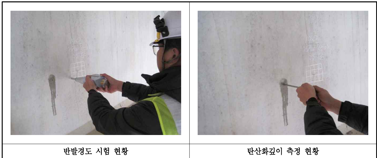
【사진 3.4.1】 콘크리트 내구성조사 현황
