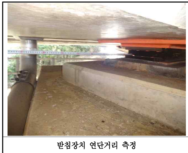
【사진 3.3.40】 교량받침장치 연단거리측정
