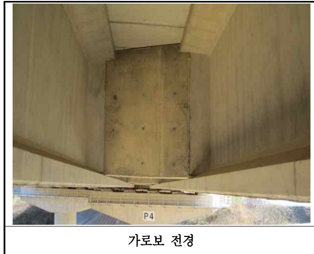
【사진 3.3.6】 가로보 전경
