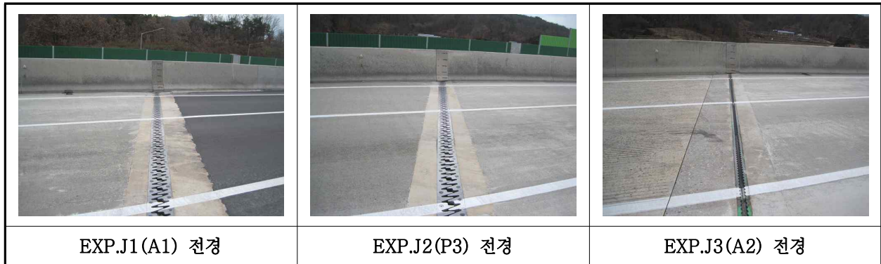
【사진 3.3.16】 신축이음장치 전경
