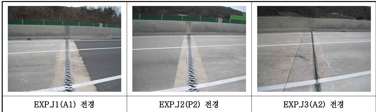
【사진 3.3.42】 신축이음장치 전경
