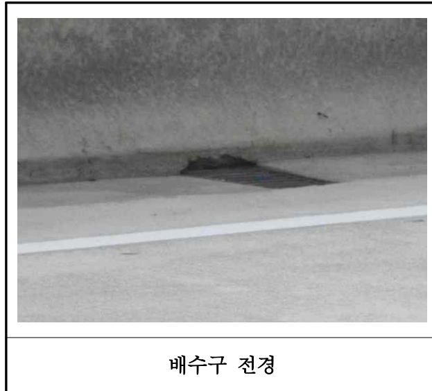
【사진 3.3.21】 배수시설 전경
