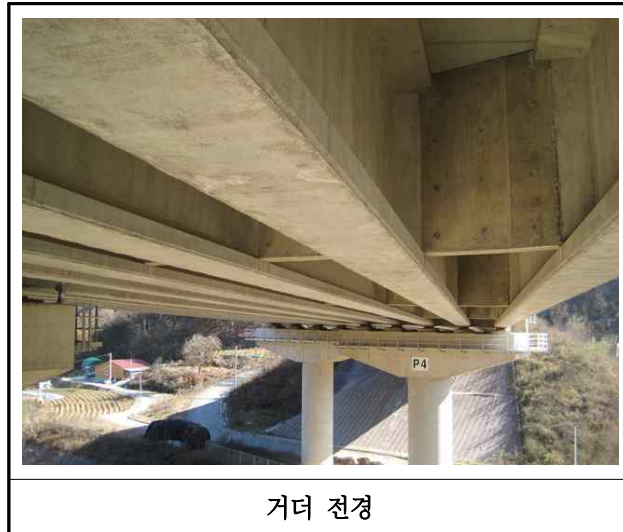
【사진 3.3.4】 거더 전경
