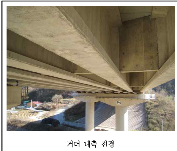
【사진 3.3.29】 거더 전경
