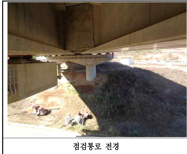
【사진 3.3.25】 교량 점검시설 전경
