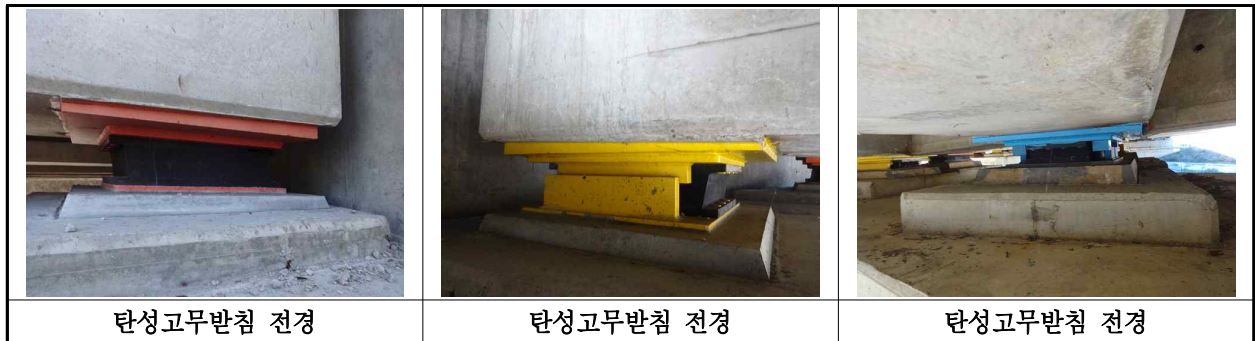
【사진 3.3.12】 교량받침 전경
