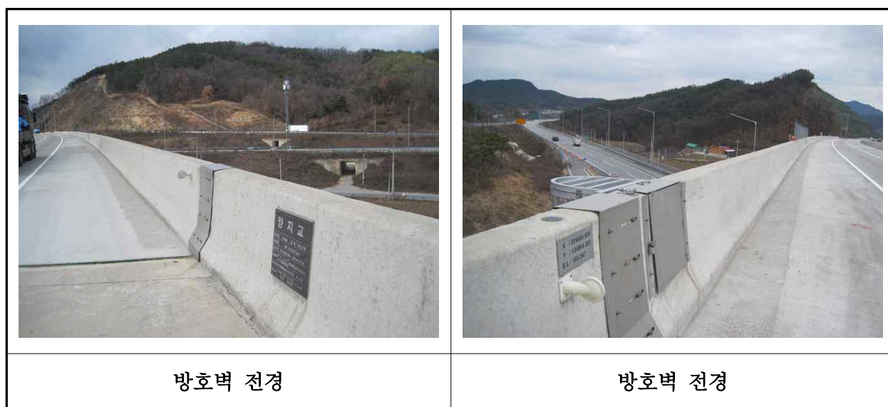
【사진 3.3.23】 방호벽 및 중앙분리대 전경
