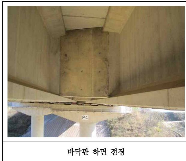
【사진 3.3.27】 바닥판하면 전경
