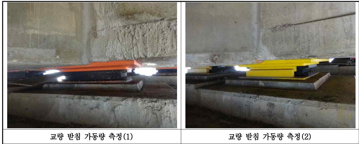
【사진 3.3.41】 교량받침 이동량 측정
