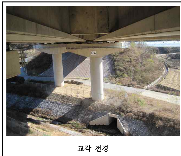
교각 전경 【사진 3.3.35】 교각 전경
